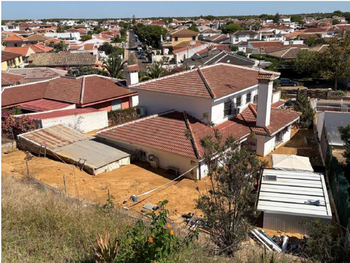
Una de las casas, inundada completamente por el barro. telecinco.es
