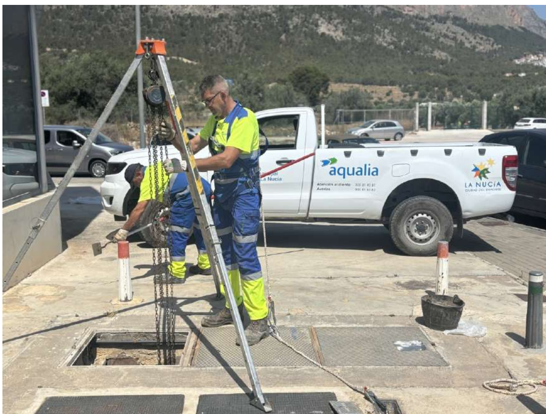
Operarios de Aqualia durante sus labores de mantenimiento de la red de suministro hídrico en La Nucia.
