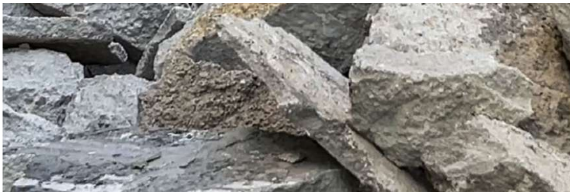
Así van las obras de la Avenida de Madrid en Jaén
