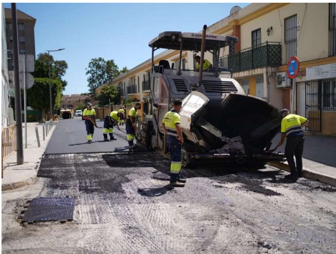
Un momento de las obras. / FOTO: AAM
