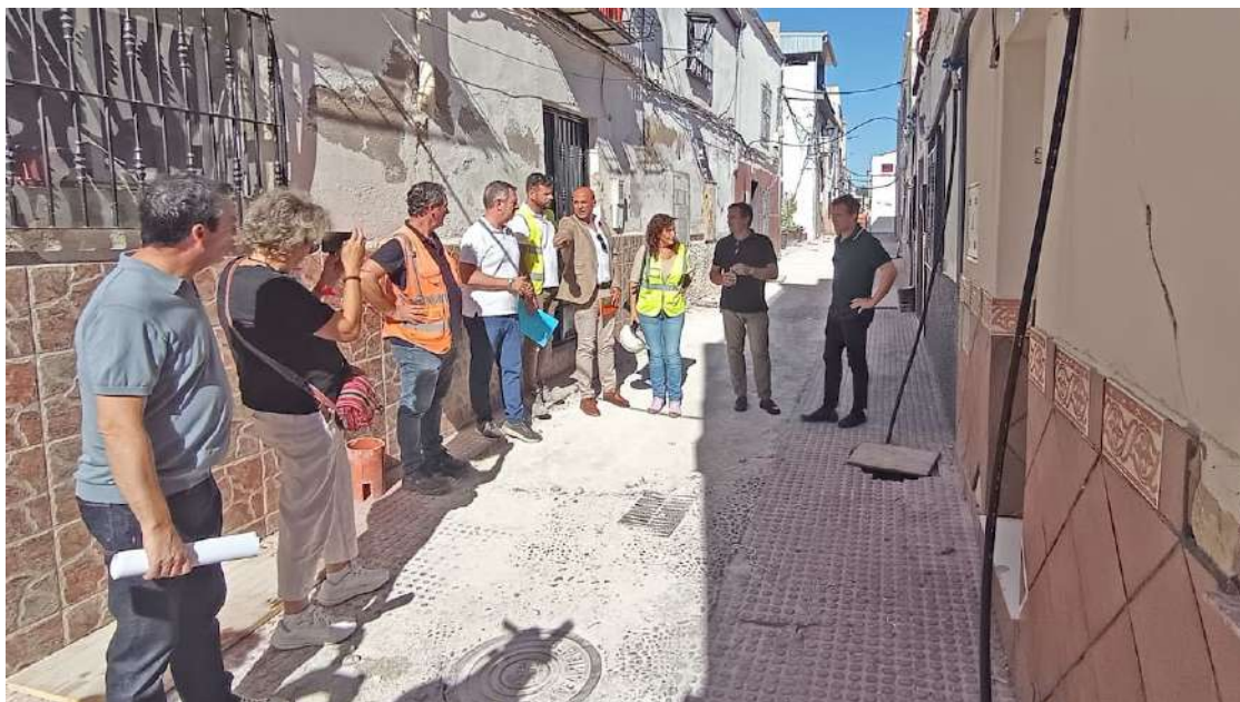
El alcalde, Julio Millán (primero por la derecha), en su visita a las obras de la calle Hospitalico acompañado de otros concejales del equipo de gobierno y de técnicos de Aqualia.
